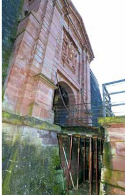
Le pont-levis de la porte de Brisach soutenu par des étais
