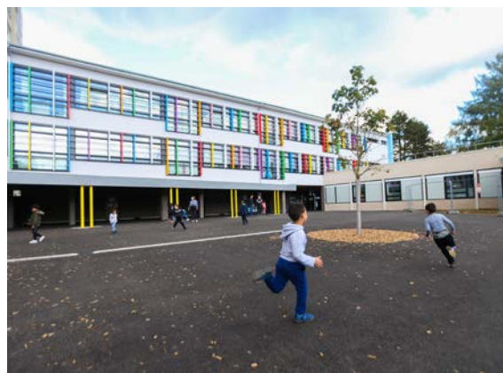
L'école élémentaire rénovée
